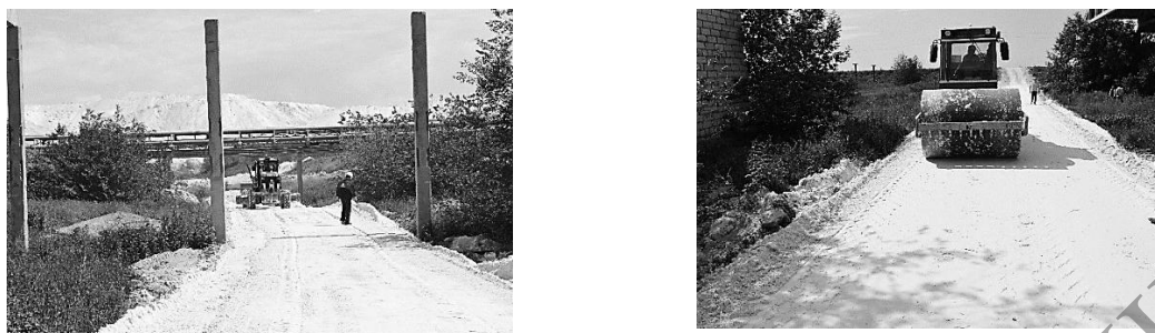
Рисунок 2. – Технология строительства дороги из вяжущего на основе фосфогипса
